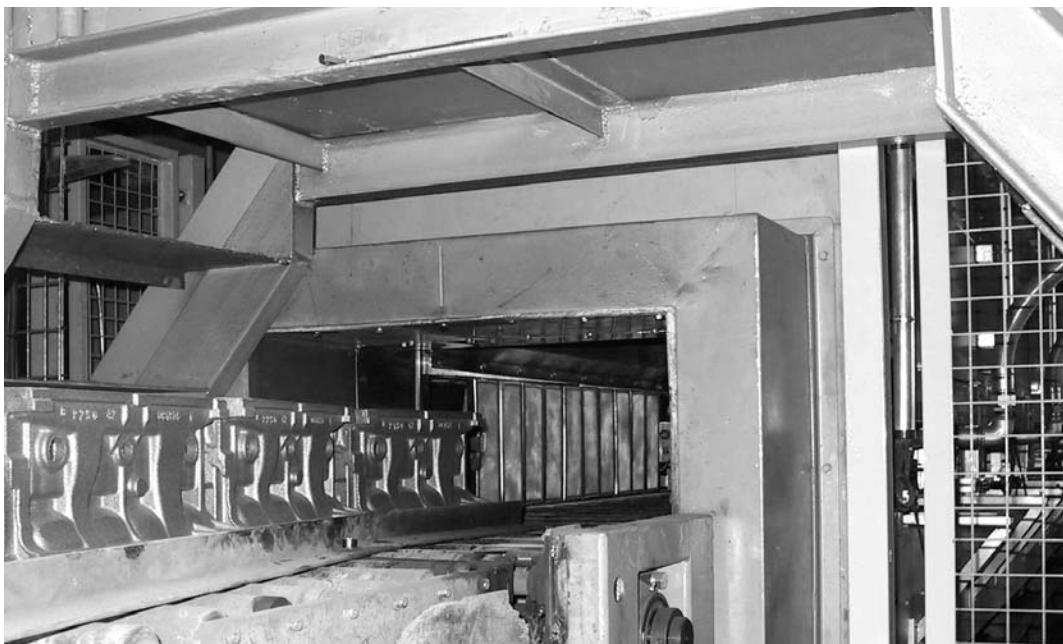
5 – Las piezas en la entrada del horno IR (se trata, en este caso, de bloques de motor recubiertos por un solo lado).
