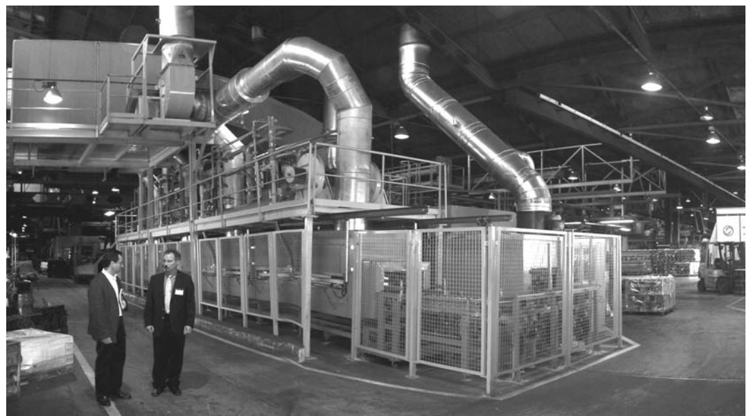
8 – El sistema automático de acondicionamiento del aire, arriba a la izquierda.
