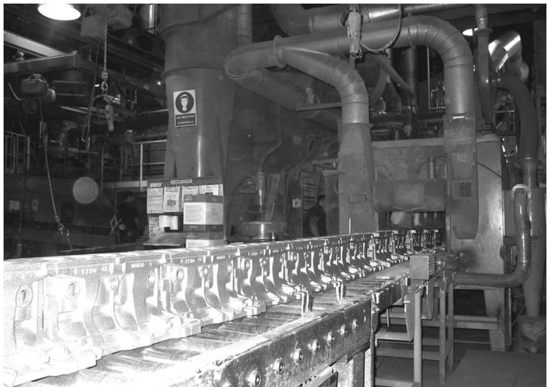
2 – La cabina de aplicación preexistente no ha variado, mientras que en cambio se ha potenciado el sistema aplicativo.
