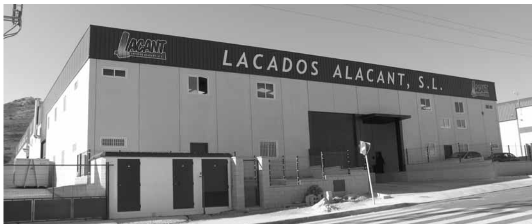
3 - La nueva planta de Lacados Alacant en Aspe (Alicante).
