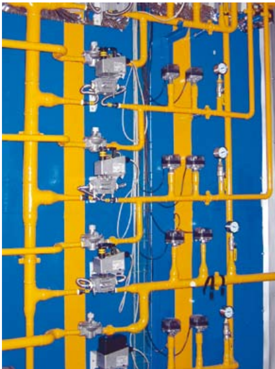
8 – Un detalle de la rampa de distribución del gas, con los controles de zona.
