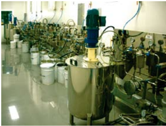
9 – La sala de distribución de las pinturas.
